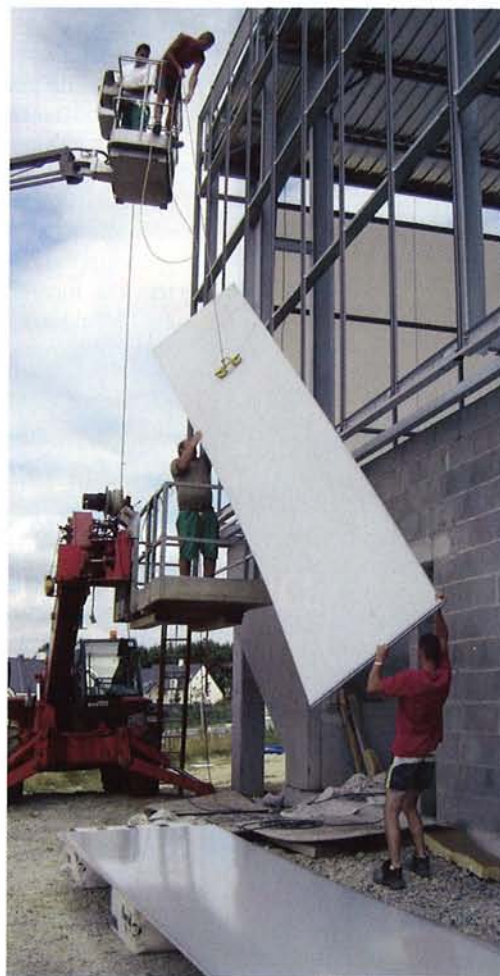
LÉGÈRES, LES PLAQUES DE BARDAGE de 6 x 1,25 m nécessitent, pour leur manutention, deux nacelles et quatre ouvriers, qui les positionnent dans les profils verticaux en aluminium laqué. (Doc. Cabot Corporation.)
